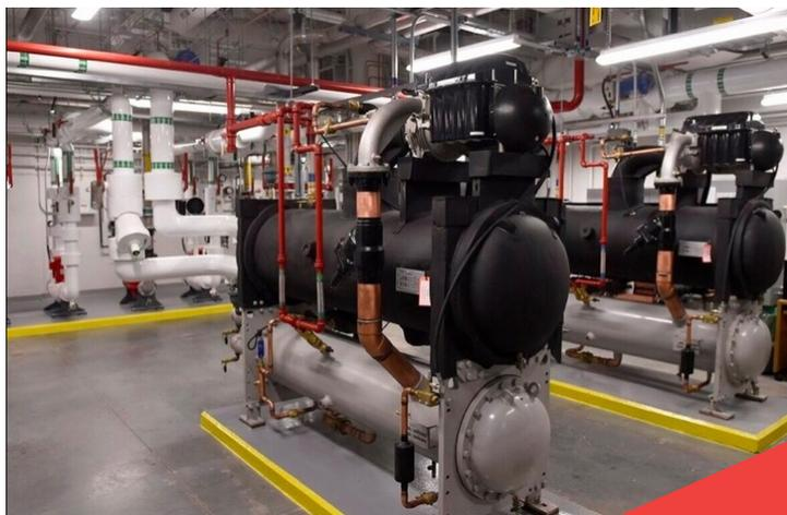
**Figure 8 :** Refroidisseurs centrifuges sans huile à haut rendement énergétique utilisés dans le Centre de valorisation des données
