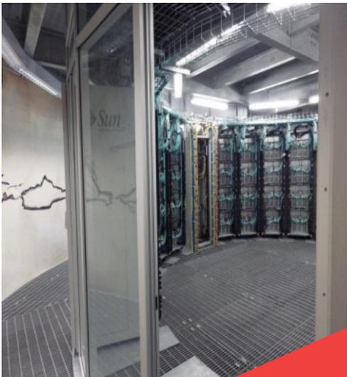
Il s'agissait donc d'un système de ventilation sans conduit d'air permettant une basse vitesse d'écoulement, une très faible pression statique en raison de la faible turbulence, et une force motrice minimale. La température d'alimentation/retour était de 19 et 32 degrés Celsius respectivement. Les lignes directrices suggèrent une plage de 18 à 27 degrés Celsius à l'alimentation. Les serveurs du Colosse opéraient donc dans des conditions favorables.
